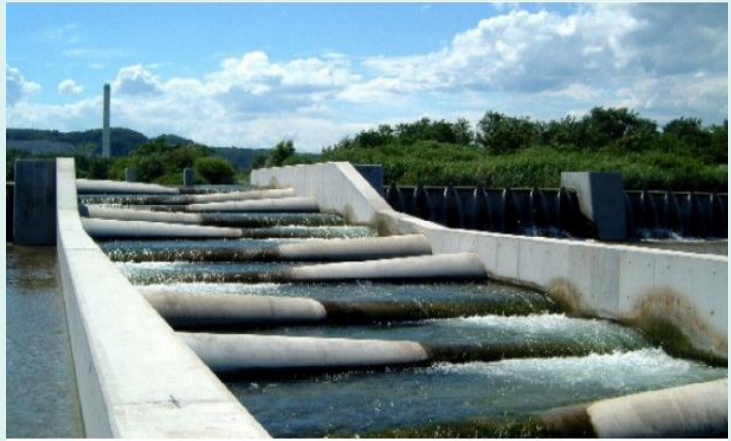
多摩川の日野用水堰に設置された魚道 64
