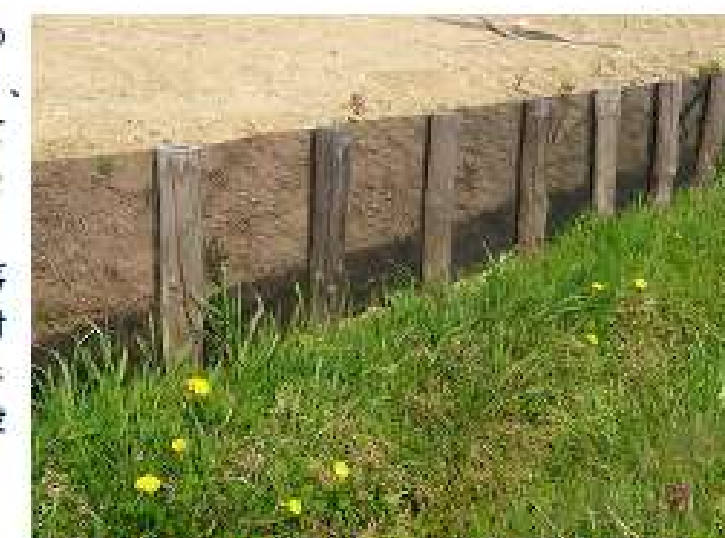
図1.9-3 FRP ネット柵の設置状況写真（例）
