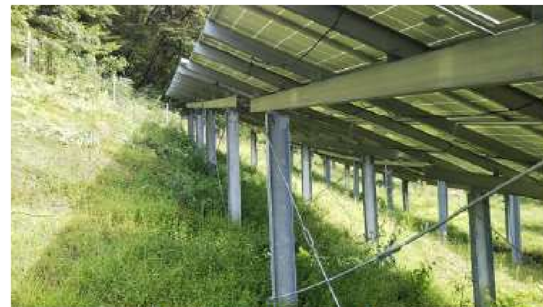
図1.9-2 杭基礎の設置状況写真（例）
