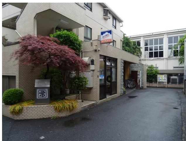
①周辺状況
