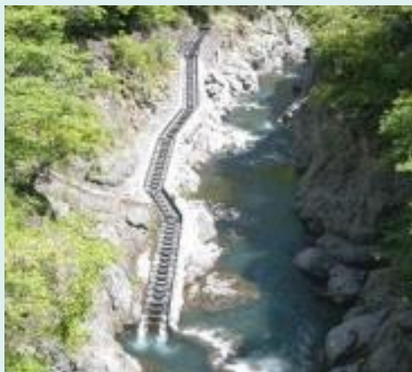
多摩川の白丸ダムの上下流を接続する魚道 65
