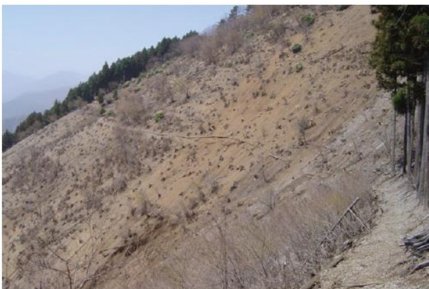
裸地化した造林地での土砂流出 平成16(2004)年(奥多摩町オオダワ)
