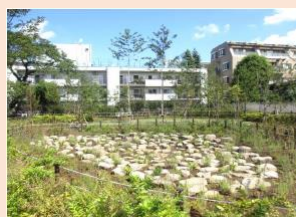
周囲に降った雨水を集めて地下に浸透させるレインガーデン（世田谷区立上用賀公園）
