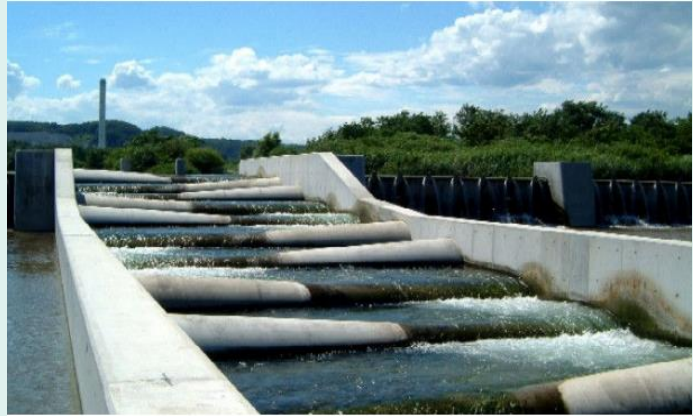
多摩川の日野用水堰に設置された魚道 66
