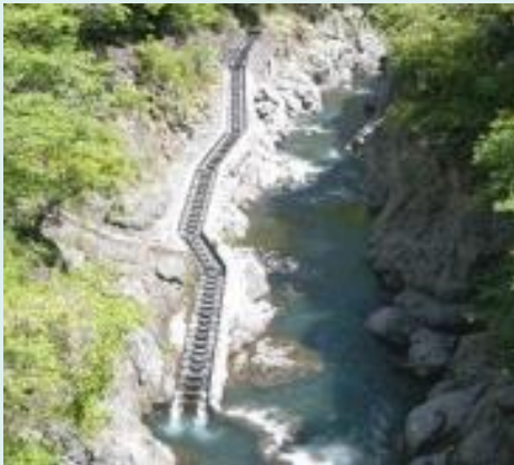
多摩川の白丸ダムの上下流を接続する魚道 64
