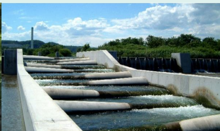
多摩川の日野用水堰に設置された魚道 47
