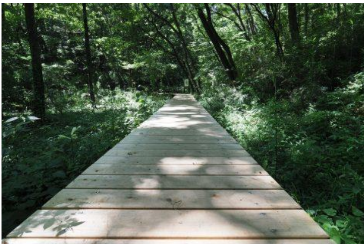
多摩産材を活用した都立小宮公園の木道 （出典：多摩産材情報センター）
