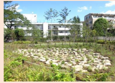
周囲に降った雨水を集めて地下に浸透させるレインガーデン(世田谷区立上用賀公園)
