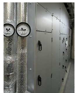
【AHU全熱交換器付】
