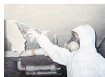
図表2-2-2-10 防護措置を講じたアスベストの除去作業
