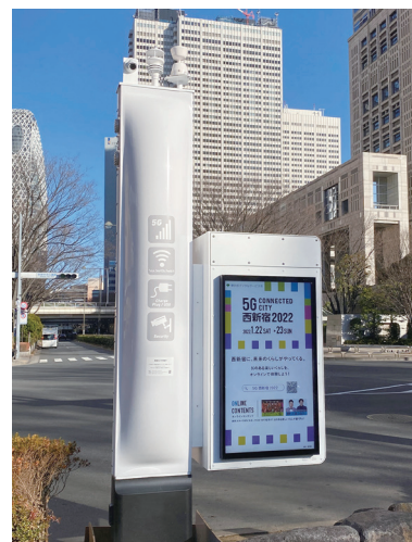
〔西新宿にある5G 基地局搭載のスマートポール〕
