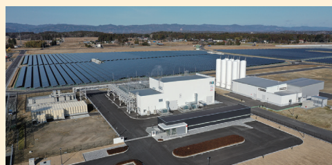
〔水素製造研究施設〕
