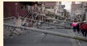
地震による電柱の倒壊
