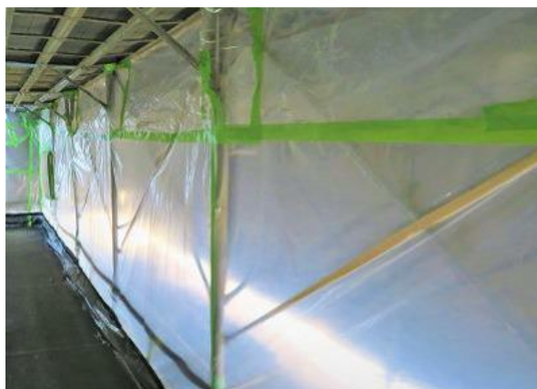
周囲への飛沫飛散防止養生例（内部）
