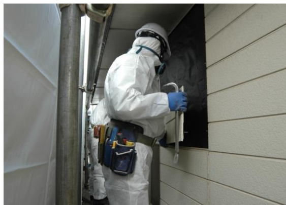
図43 原形のままの手ばらし（外装）
