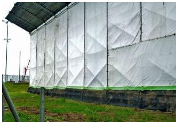
周囲への飛沫飛散防止養生例（外部）
