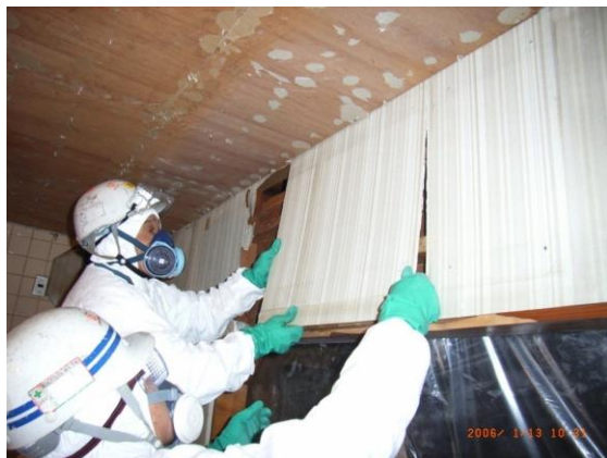
図39 手ばらしによる成形板の除去
