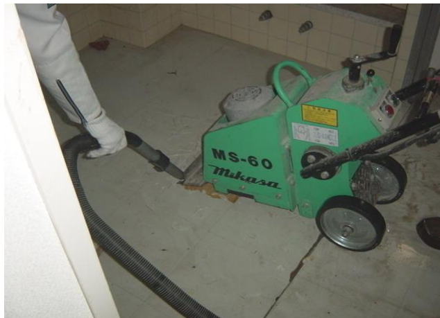
図41 HEPAフィルタ付真空掃除機を使用しながらのビニル床タイル除去作業
