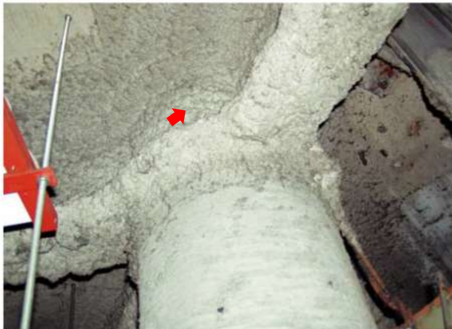
写真1 吹付け石綿の使用例（鉄骨の耐火被覆材として吹付け） 8)
