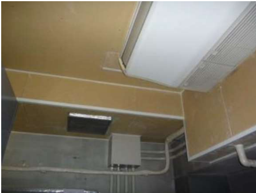
写真 19 囲い込み施工例
