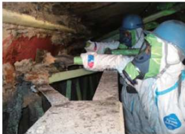
写真 17 石綿の除去作業 16)
