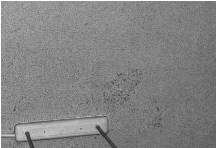
写真 14 局所的な表面の毛羽立ちのある吹付け石綿の例（天井面）
