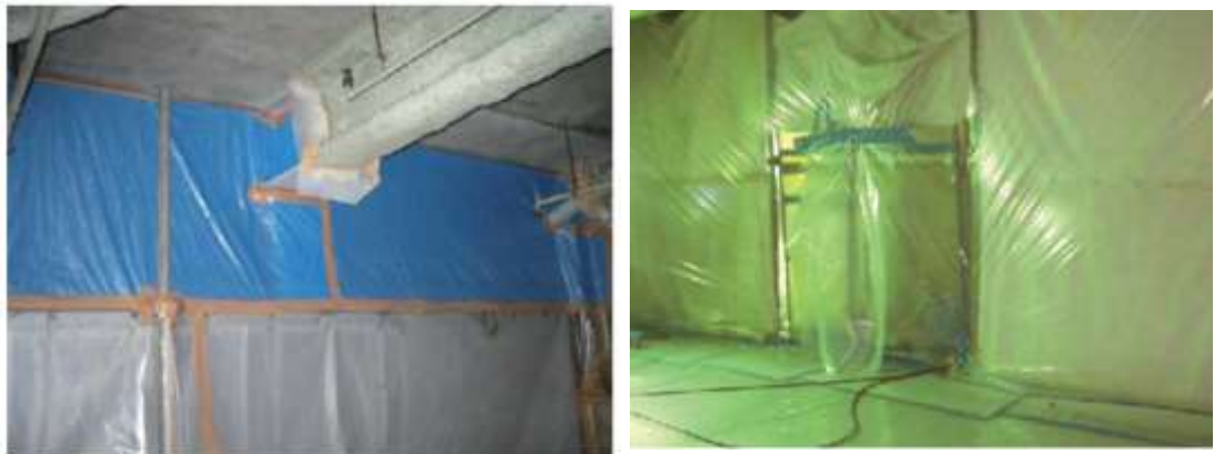
写真 15, 16 プラスチックシートによる隔離例 16)
