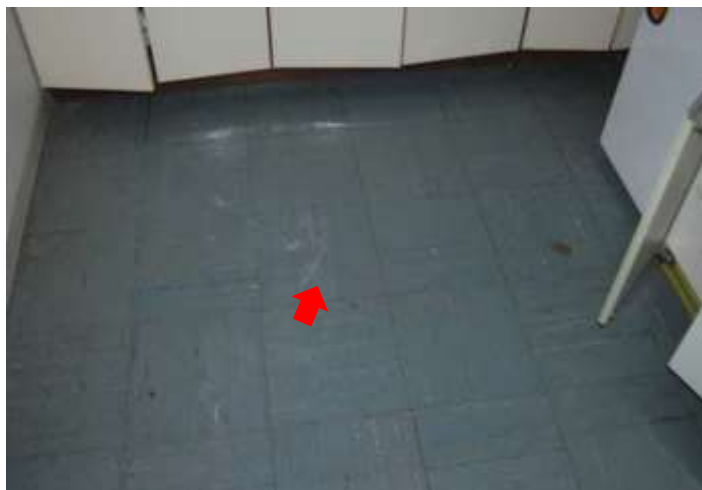
写真9 ビニル床タイルの使用例 8)
