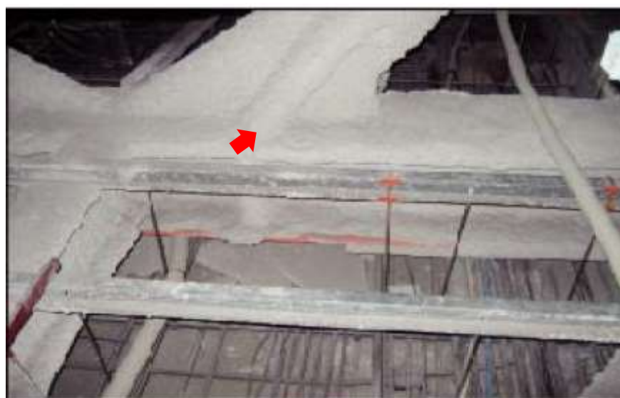
写真3 石綿含有吹付けロックウールの使用例② 8)
