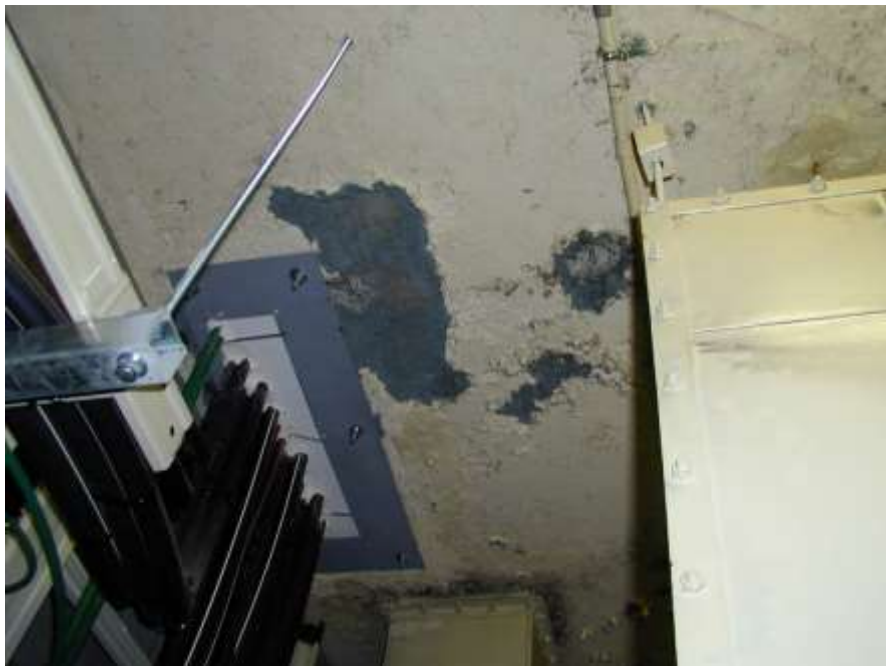
写真 12 損傷・欠損に至った吹付け石綿の施工例
