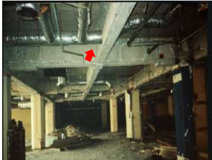
写真 5 石綿含有耐火被覆材の使用例（鉄骨に張り付けて使用） 8)
