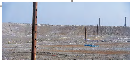
写真9 ガス抜き管 (参考)
