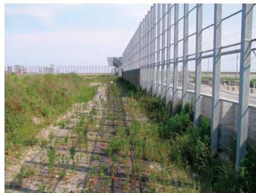
写真10 ごみ飛散防止フェンス
