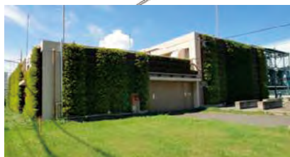
写真6 ガス有効利用施設発電機棟
