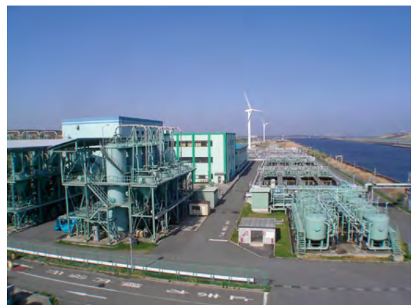
写真4 第三排水処理場(内側埋立地)
