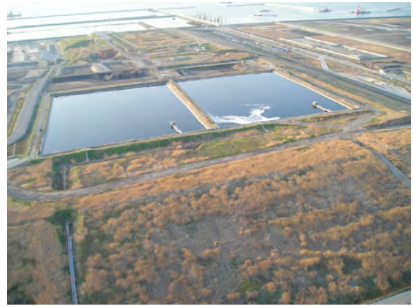
写真2 調整池(外側埋立処分場)
