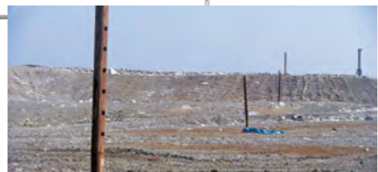
写真9 ガス抜き管 (参考)
