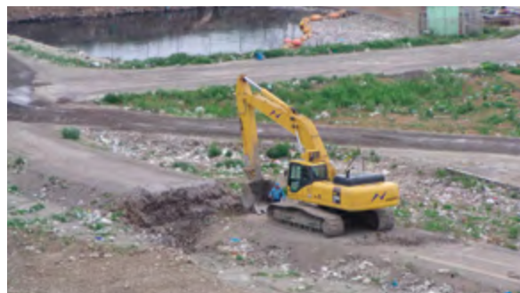
写真12 作業用道路整備（路盤材再利用）
