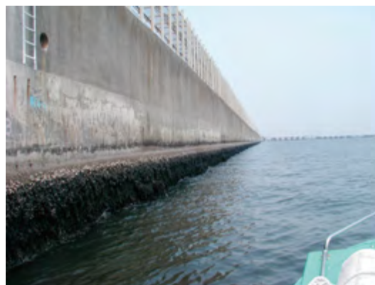
写真11 護岸点検（東側）
