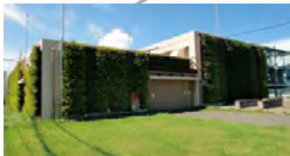
写真6 ガス有効利用施設発電機棟
