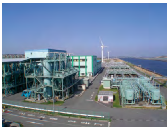
写真4 第三排水処理場(内側埋立地)
