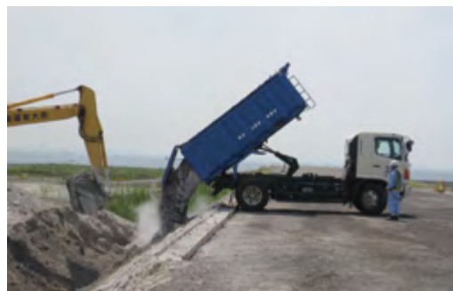
写真14 搬入廃棄物の監視等
