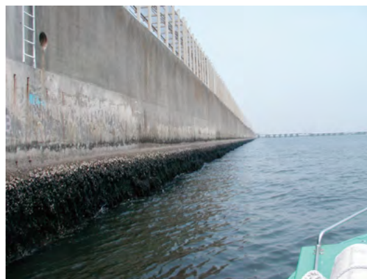
写真11 護岸点検（東側）
