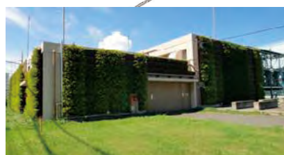
写真6 ガス有効利用施設発電機棟
