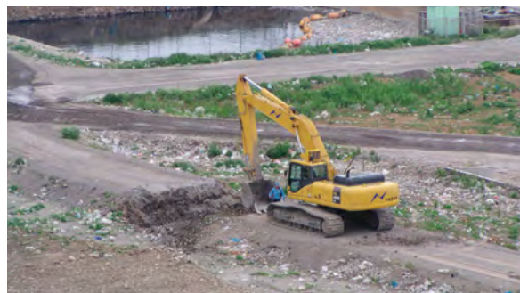
写真12 作業用道路整備（路盤材再利用）
