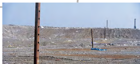
写真9 ガス抜き管 (参考)
