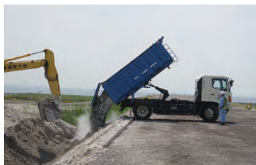
写真14 搬入廃棄物の監視等
