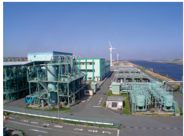
写真4 第三排水処理場(内側埋立地)
