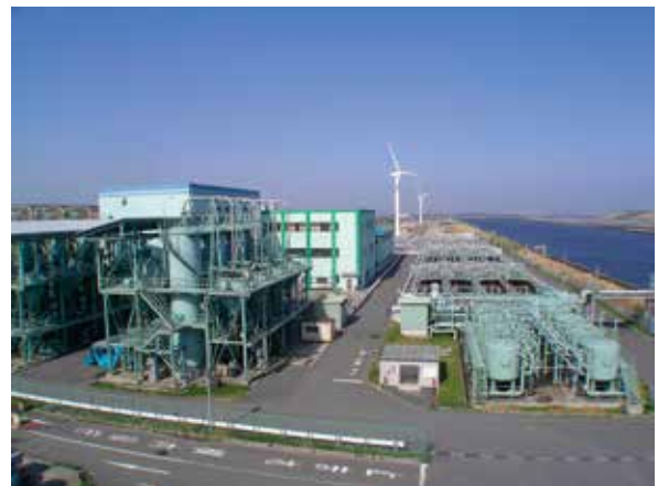
写真4 第三排水処理場(内側埋立地)
