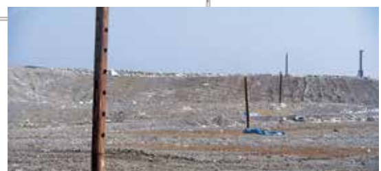
写真9 ガス抜き管(参考)
