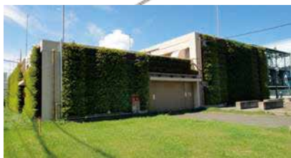
写真6 ガス有効利用施設発電機棟
