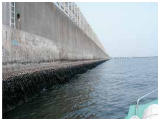
写真11 護岸点検(東側)
