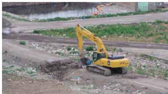
写真12 作業用道路整備（路盤材再利用）
