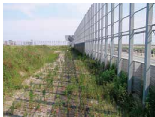
写真10 ごみ飛散防止フェンス
