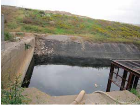
写真1 集水池(ポンプ井)(外側埋立処分場)
