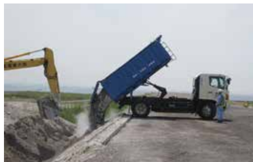
写真14 搬入廃棄物の監視等
