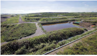
集水池（ポンプ井）
