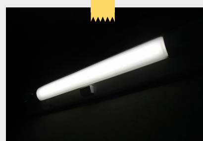
【階段非常照明（LED灯）】
