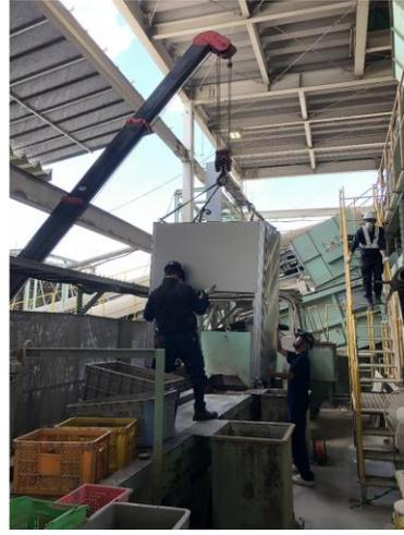
図 4-44 カメラ BOX の配置・据付 (写真)
