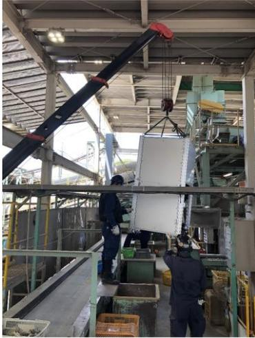
図 4-43 カメラ BOX の移動作業 (写真)
