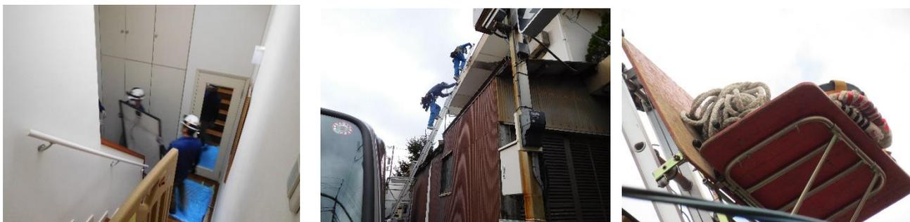
図 5.22. 屋根へのアプローチ（左から屋内経路、はしご、荷揚げ機）
