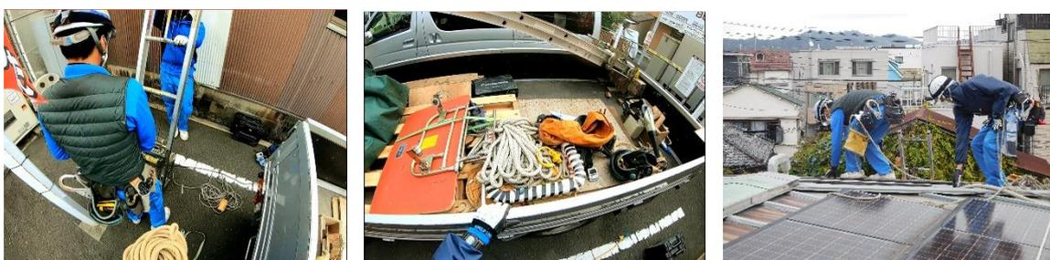
図 5.21. 機材（左から、安全帯、持ち込み機材、安全帯使用状況）
