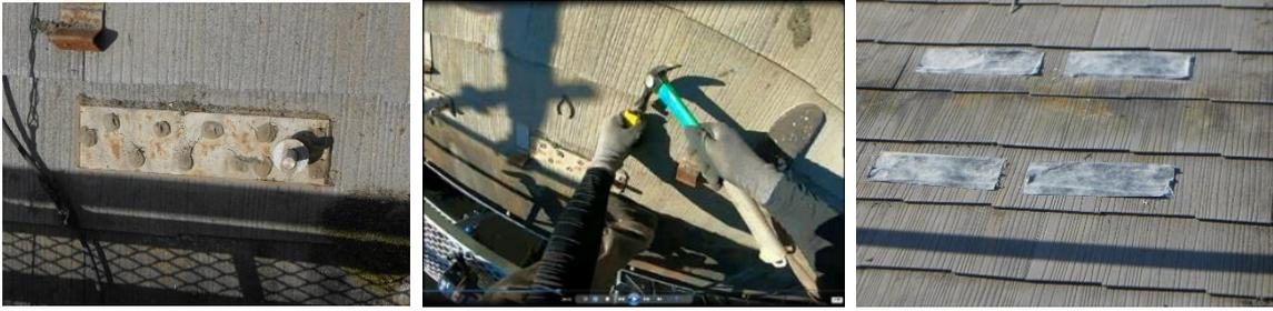
図 5.23. ベース取り外し作業（左から、ベース板、剥離作業、養生後）
