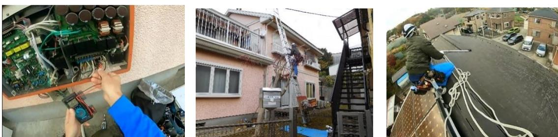
図 5.20. 作業風景（左から、系統切断確認、荷揚げ機設置、安全索張り）
