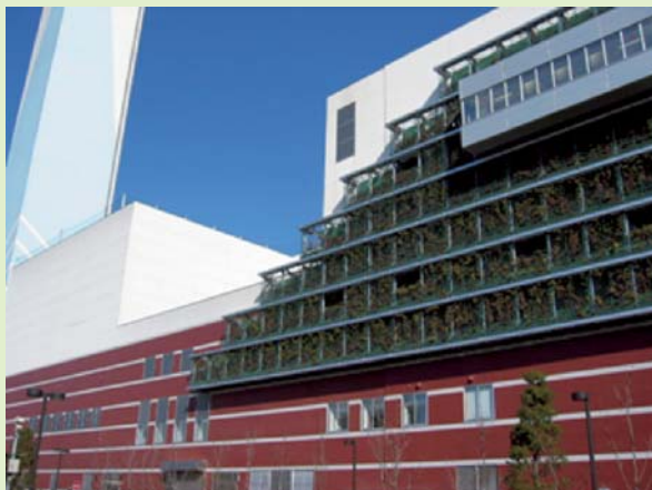
東京都板橋清掃工場の壁面緑化
