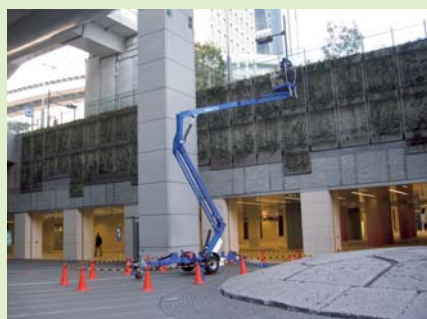
高所作業車による管理
