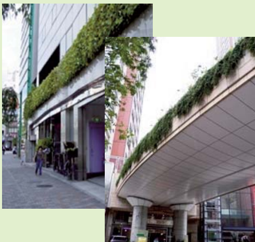
エントランス上部や橋梁での壁面緑化
