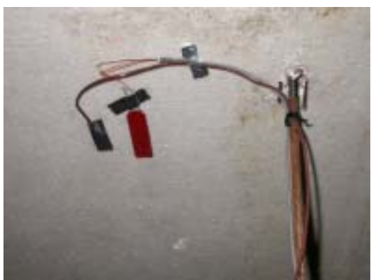
熱流計・熱電対設置状況（天井内）
