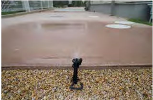
写真 4-23 保水性舗装と散水 13
