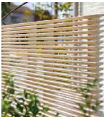
写真 4-24 冷却ルーバー 14
