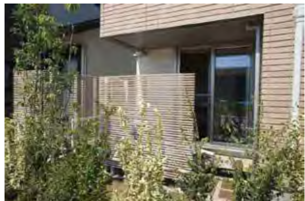
写真 4-25 冷却ルーバー 15
