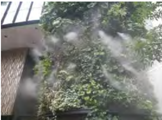
写真 4-28 壁面緑化とドライ型（微細）ミスト 19
