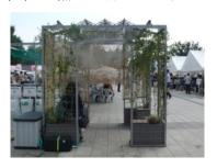
ドライ型(微細)ミスト +360 度ファン ポール上部の周囲に配置され ミストを装着 たノズルからミストを噴霧
