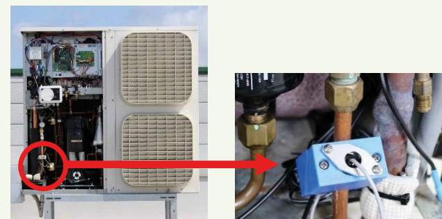
＜冷凍設備への超音波センサー設置イメージ＞
