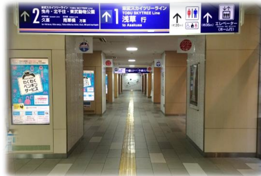
駅照明のLED化
