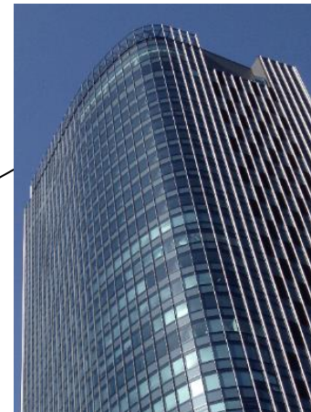
東京スカイツリーイーストタワーのLow-Eガラスと縦ルーバー
