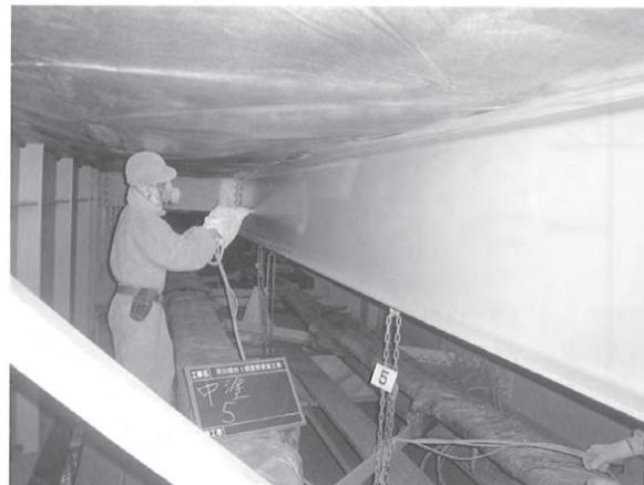
付図 4-2 静電工アラップエアレス塗装法を用いた施工状況
