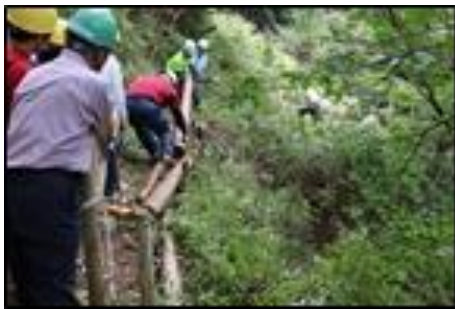
作業道を整備
