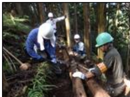
斜面地に新しい道を作る様子
