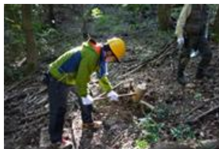
掛矢を使って縦杭を固定
