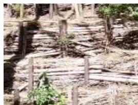
斜面の土留め
