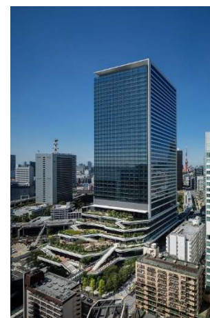
周囲の緑の連続性を拡充するスキップテラス
