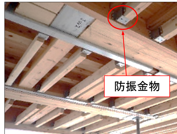
遮音床施工状況
