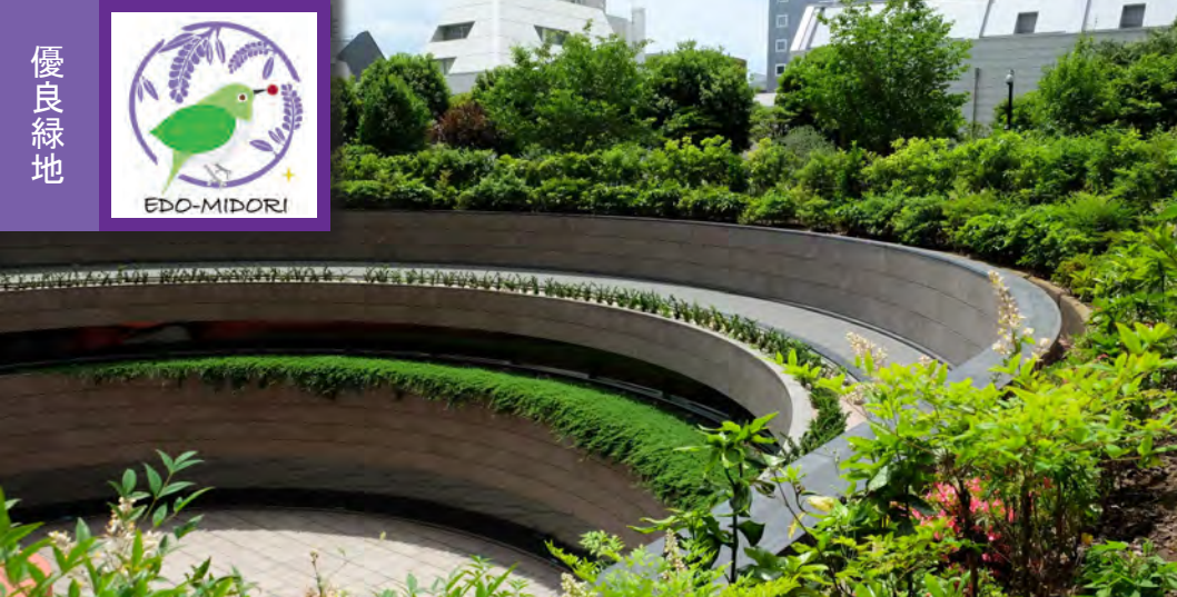
▲屋上庭園全景
