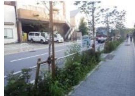
排水性舗装と道路植栽帯を組み合わせ、車道に振った雨を植栽帯に導き、雨水をより効果的に浸透させている（区画街路7号線）。
