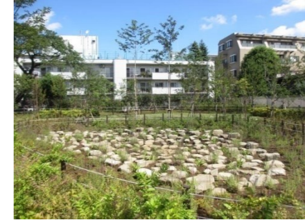
レインガーデンと呼ばれる、周囲に降った雨水を集めて地下に浸透させるくぼ地状の植栽地を整備（区立上用賀公園）。
