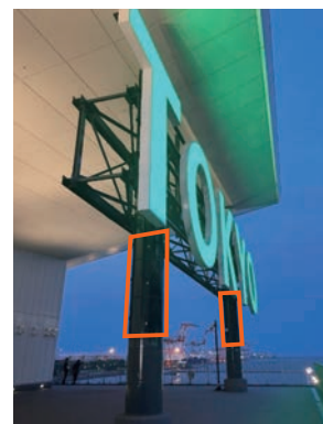
港湾施設の柱に設置した Airソーラー
