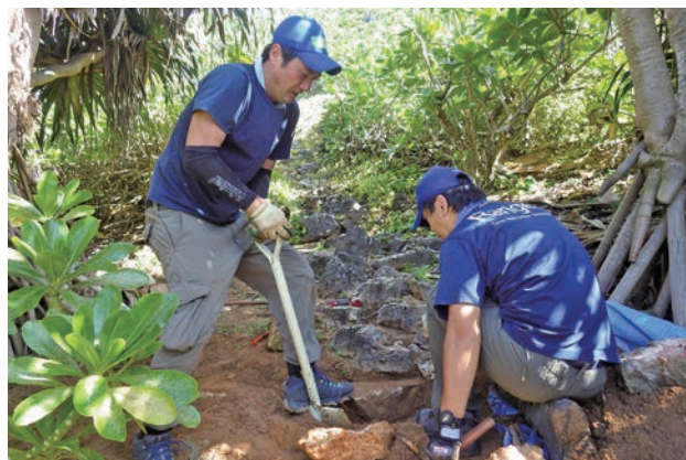
都レンジャーによる登山道の整備
