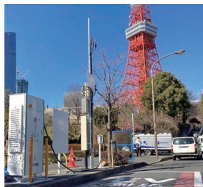
公道（パーキングメーター設置エリア） の充電設備の設置
