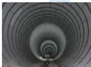
神田川・環状七号線地下調節池
