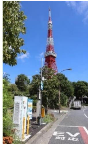
公道充電設備（芝公園付近）
