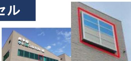
建材一体型PVの窓・壁への設置事例
