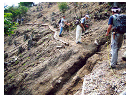
写真：斜面の崩壊
