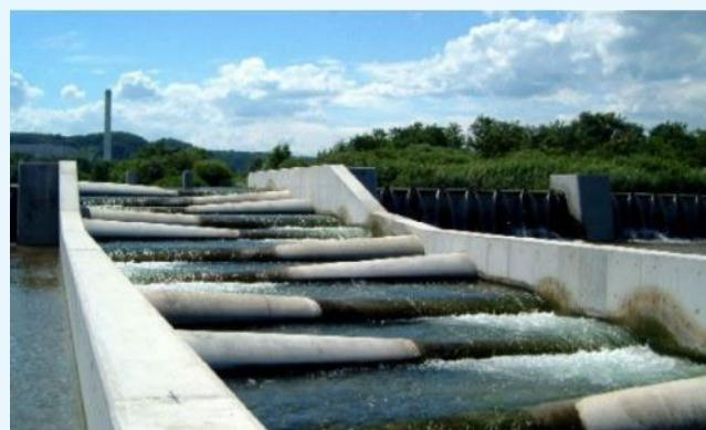
多摩川の日野用水堰に設置された魚道<sup>66</sup>
