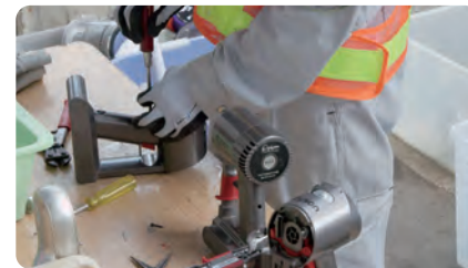
リチウムイオン電池等を取り除く作業
