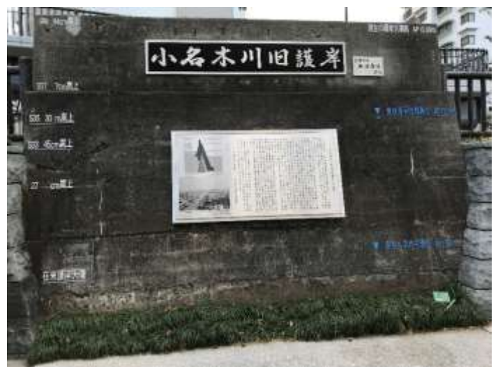
図 7-10 小名木川のかさ上げ護岸の変遷と旧護岸(東京都江東区北砂 5 丁目)
