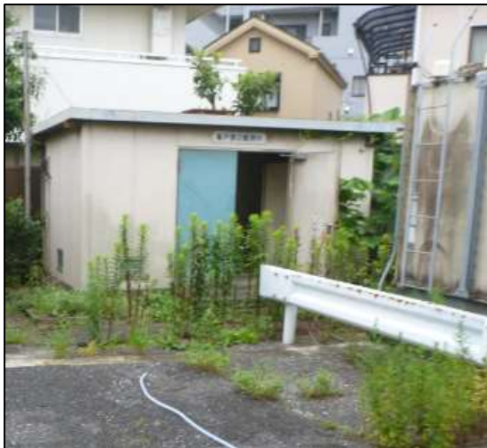
観測井の外観
