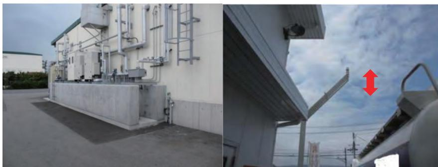
設備等のかさ上げ、通気管のかさ上げの例
