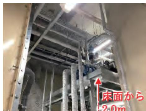
受変電設備を屋上に設置した例、受水設備のかさ上げの例
