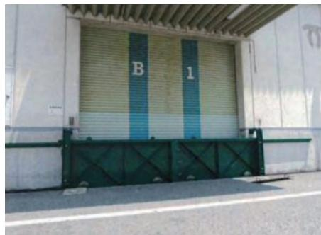
開口部設置型止水板（起立式、スライディング式）の例
