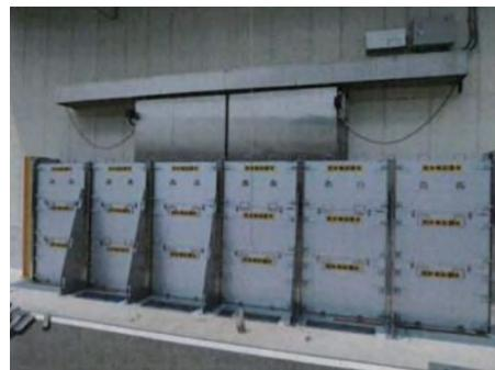
脱着式止水板（連続構造）の例
