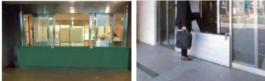
止水シート、簡易止水板の例
