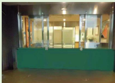
止水シートの設置※2
