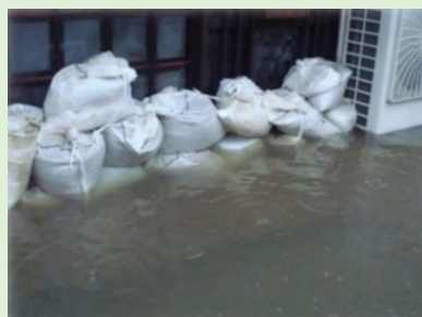
土のうの設置※1
