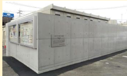
受電設備の囲い塀の設置※2
