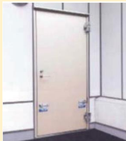
防水扉の設置※2
