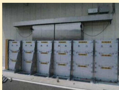
止水板の設置※4
