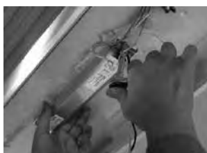
↑ 取付工事写真
