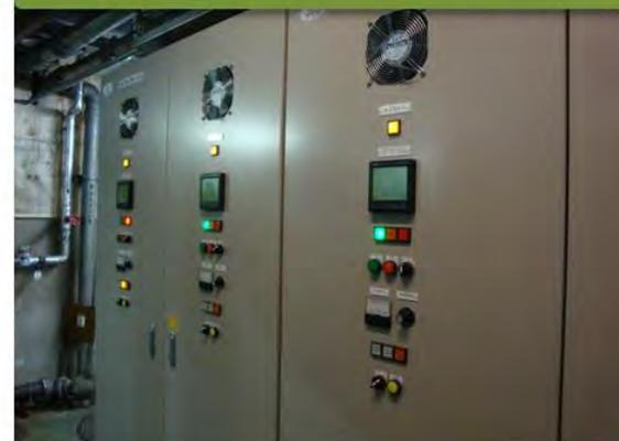
インバータ化により、ポンプの消費電力を大幅に削減！
