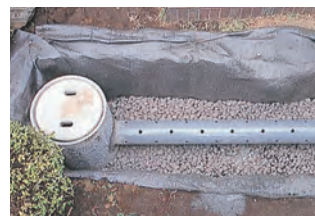
雨水浸透ます・浸透管
