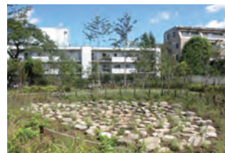
周囲に降った雨水を集めて地下に浸透させるレインガーデン（世田谷区）
