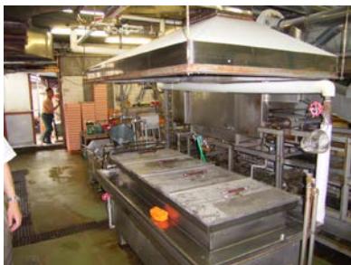
局所換気システムの例
