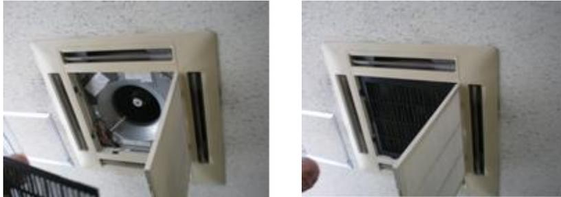
フィルターの装着場所のイメージ(室内機ごとにフィルターが設置されています)
